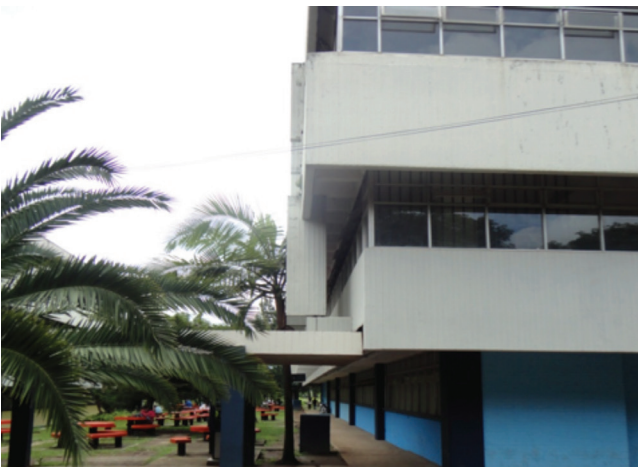
Vista fachada nor-este.
