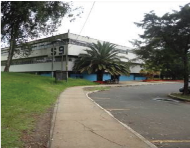
Ingreso al edificio por estacionamiento, poniente.
