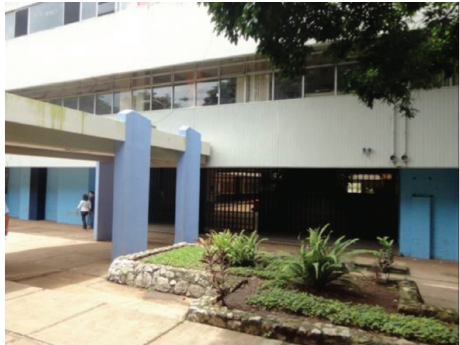
Acceso del lado oriente del edificio.
