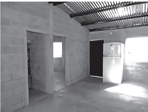
Fotografía 3, muestra el interior con vista el área privada y los materiales de construcción
