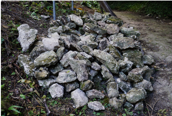
Figura 9. Vista parcial actuales trabajos de restauración Templo V. Fotografía: Wendy Estrada agosto 2021
