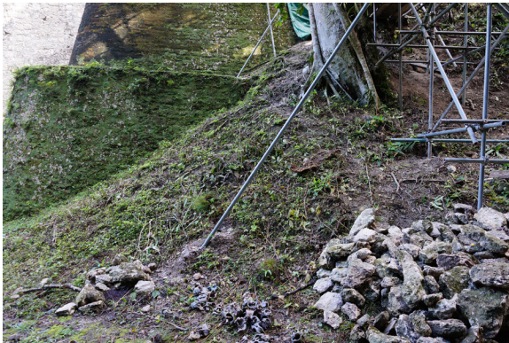
Figura 10. Vista parcial actuales trabajos de restauración Templo V. Fotografía: Wendy Estrada agosto 2021.
