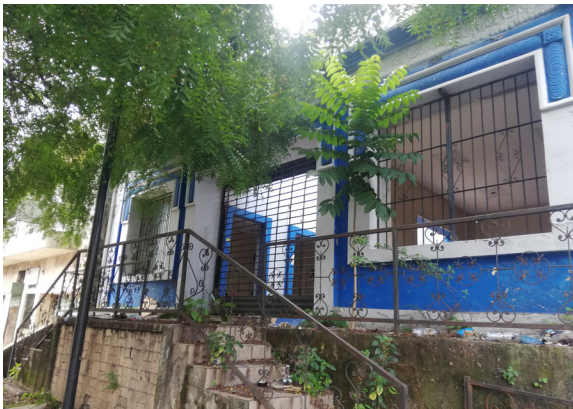
Figura 3. Inmueble que se puede destinar para el Museo de la Calle Real, mediante un proyecto de restauración y readecuación del inmueble.
