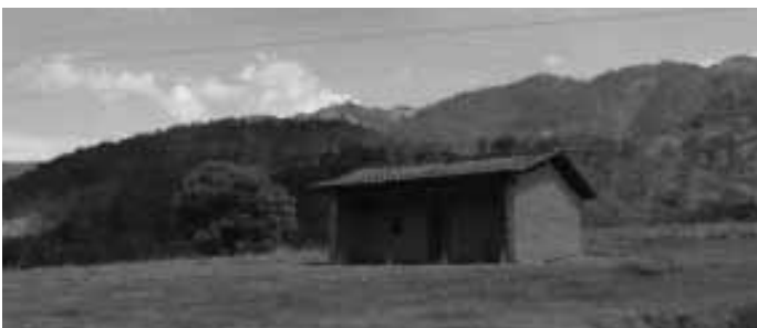
Figura 15 Casa típica en teja, columnas de madera y adobe.
