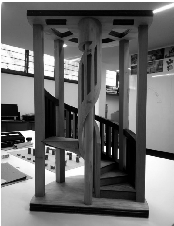
Figura 10 Modelo físico de las escaleras helicoidales de madera de la Catedral Metropolitana de la Ciudad de México. Realizado por Evelyne Campos Lara. 2019, Fotografía por Evelyne Campos Lara.
