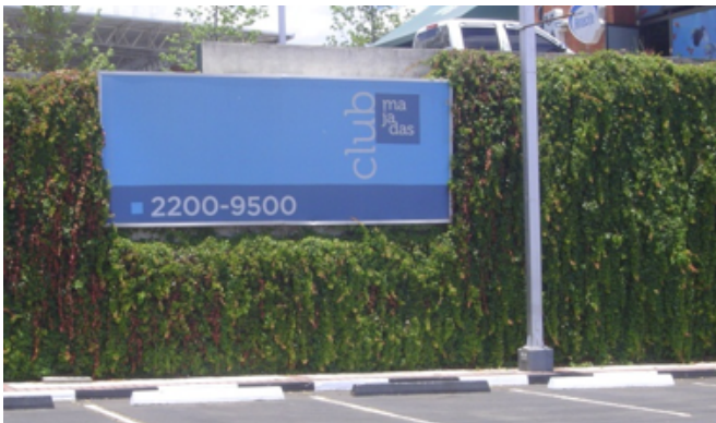
Figura 7. Godínez R. Muro de contención que no es atractivo, cambia con una cubierta verde como cortina y se aprovecha para incorporar una valla o rótulos comerciales. Marzo 2014. Estacionamiento de "Restaurante los Cebollines" Comercial Majadas zona 11 ciudad de Guatemala.
