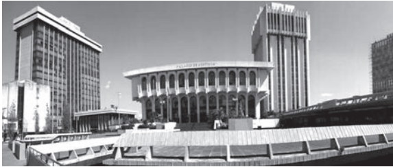
Figura No.12: Edificio de Finanzas y Torre de Tribunales. (2018) Fuente: Sonia Fuentes.
