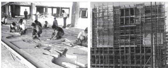
Figura No.14 y 15: Fabricación in situ de la formaleta para los alto relieves del Crédito Hipotecario. Fuente: Archivo Crédito Hipotecario Nacional (1962).
