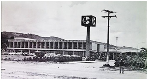
Figura 5. Química Hoechst en Calzada Roosevelt, Mixco, Guatemala, 1968. Fuente: Reproducción de archivo de Max Holzheu.
