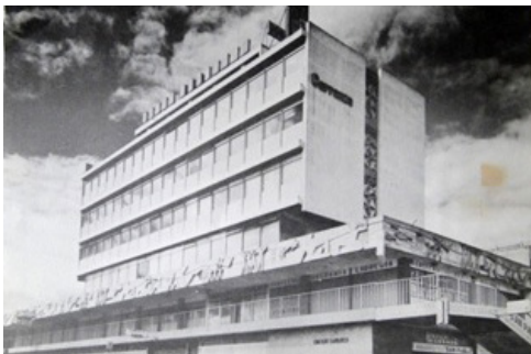
Figura 1. Edificio de Hotel Terminal o Edificio Carranza. Nota: En la planta baja mural de Dagoberto Vásquez Fuente: Reproducción de archivo de Max Holzheu.
