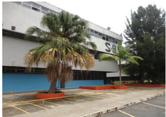
Vista desde el estacionamiento poniente, se puede observar las barandas en piso que son un elemento que aumenta la vulnerabilidad al momento de una evacuación de emergencia.
