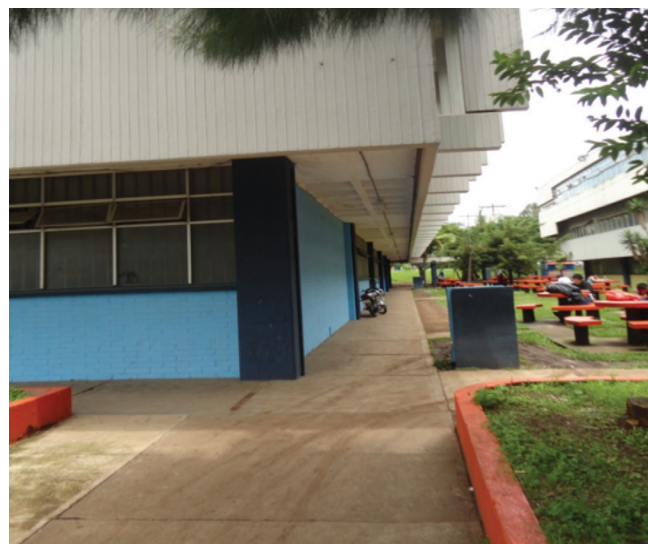
Pasillo exterior lado sur, elemento de interconexión exterior con el edificio S-10.
