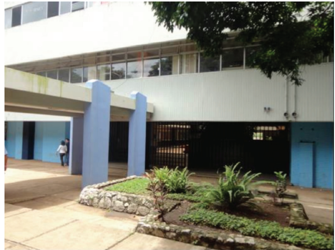
Acceso del lado oriente del edificio.
