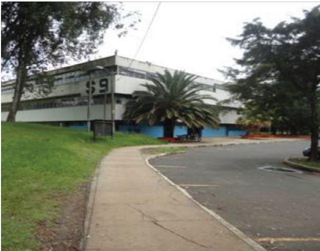
Ingreso al edificio por estacionamiento, poniente.
