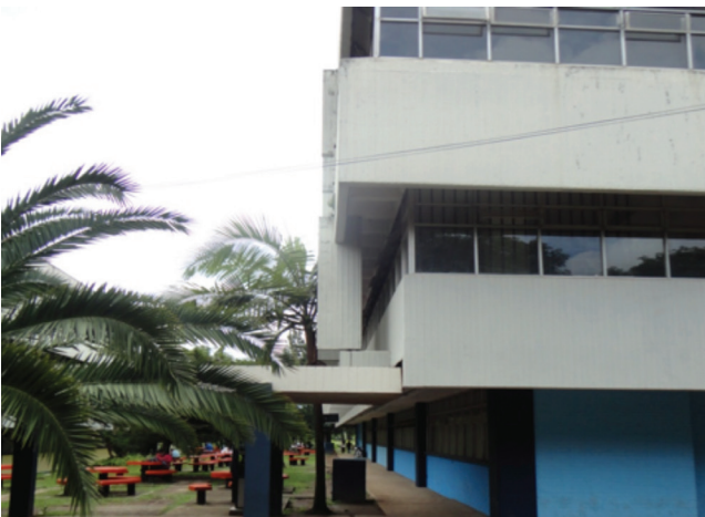
Vista fachada nor-este.
