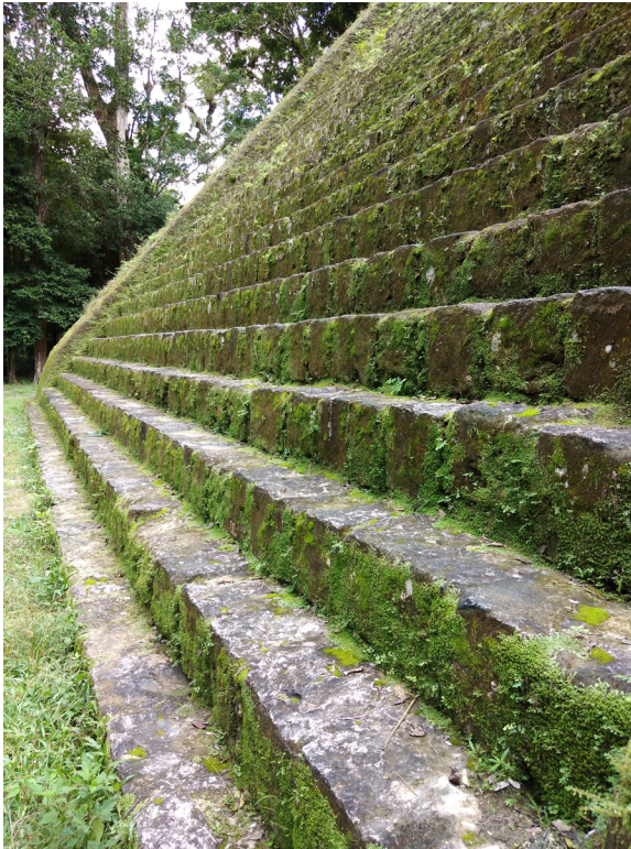
Figura 12. Vista parcial de la fachada frontal perspectiva Nor-Oeste del Templo V. Trabajos de integración cromática con una mezcla de mortero de cal y tierras locales, que permiten el rápido crecimiento de microflora, necesaria para la protección y transpiración propia del edificio Fuente de información: AECID 2013 Fotografía: Wendy Estrada diciembre 2020
