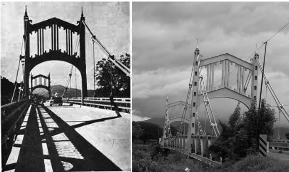
Figura 2. Inauguración de este puente, el 16 de septiembre de 1937, Informe de Labores. El puente fue donado por el gobierno de Estados Unidos, y armado e instalado por personal guatemalteco. Derecha, foto propia, julio de 2010.
