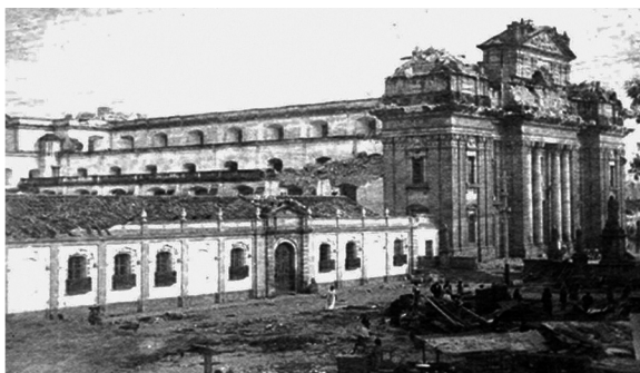
Figura 7. Destrucción de la plaza. Vista noroccidente de la Catedral de la Nueva Guatemala de la Asunción, en la que se observa en la parte superior derecha, los daños ocasionados por el terremoto de 1917 y 1918, que provocó el derrumbe de las torres campanario. En la parte inferior derecha parte del atrio de la catedral y obras provisionales derivadas del terremoto. Fotografía de: Sergio Cruz tomado del Centro Histórico en Guatemala citando a Foto Rex, 2014. Consultado en línea, enero 2021. http://centrohistoricoenguatemala.blogspot.com/search/label/Archivo%20Foto%20Rex .
